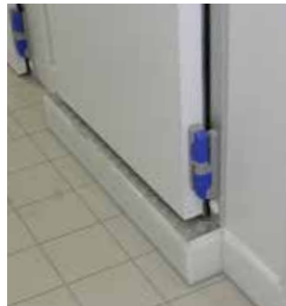
Seuil de chambre froide
