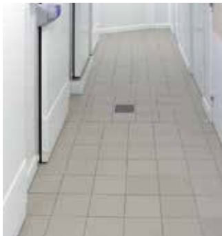
Couloir chambre froide
